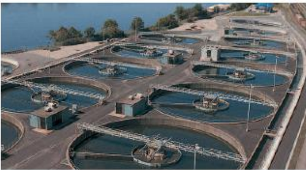
2 Absetzbecken einer Kläranlage
